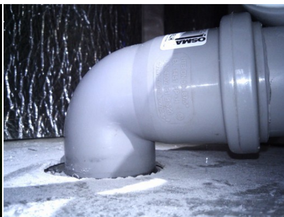
Propojení odpadu na dně vířivky - koleno
